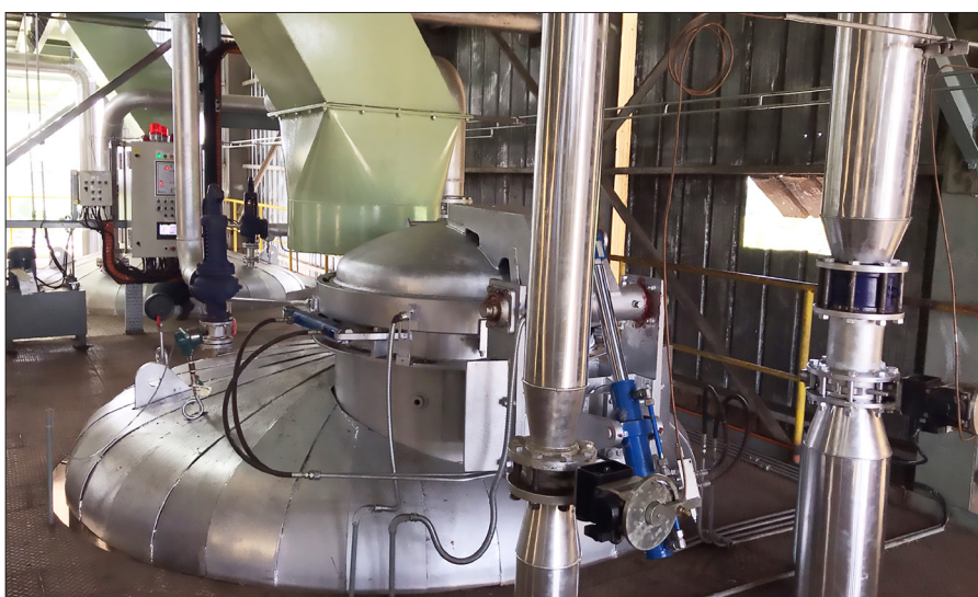
◀ การติดตั้งหม้อน้ำปาล์มใหม่
