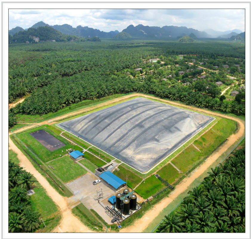
ภาพหลังจากเปลี่ยนฝักคลุมบ่อหมักไบโอแก๊สเรียบร้อยแล้ว
