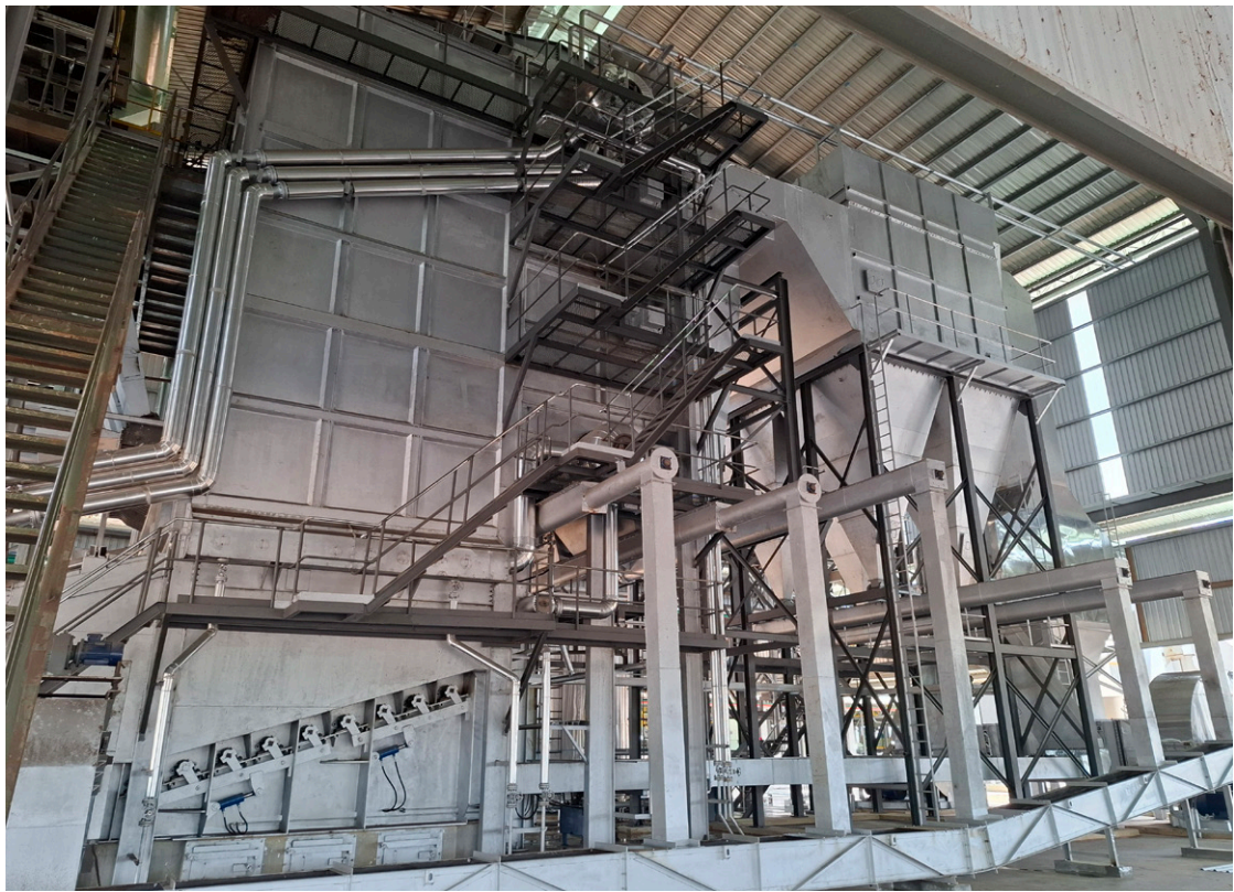
หม้อไอน้ำ ของ โรงงานชะอวด
